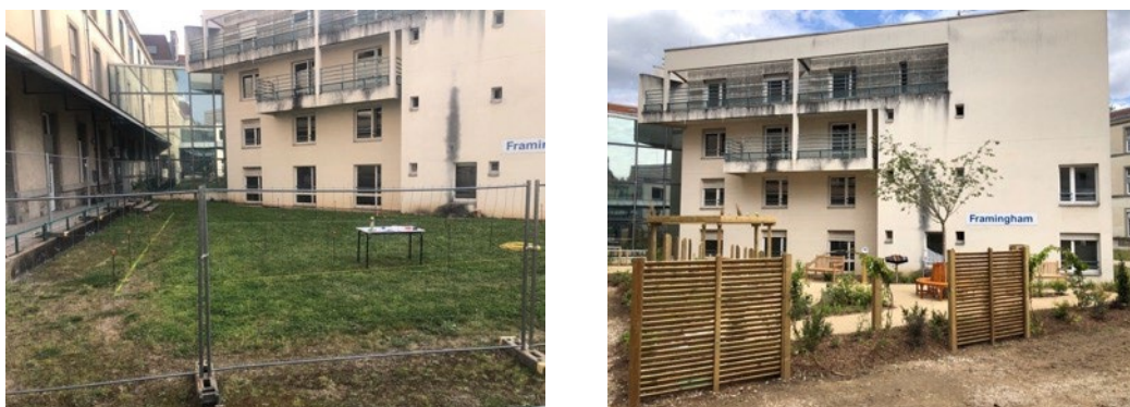
Annexe 5 Figure 1 : Avant et après travaux de construction du jardin des promenades enrichies
